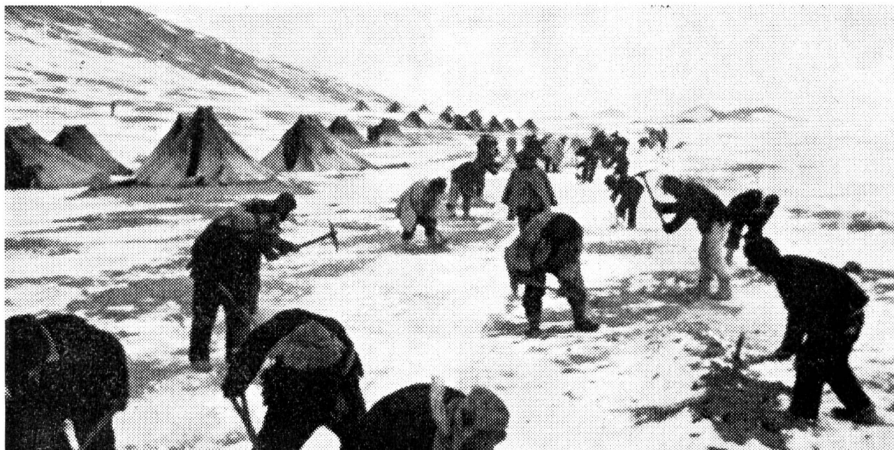
Erbarmungslos werden die Tibeter als Arbeitssklaven beim militärischen Strassenbau eingesetzt.
