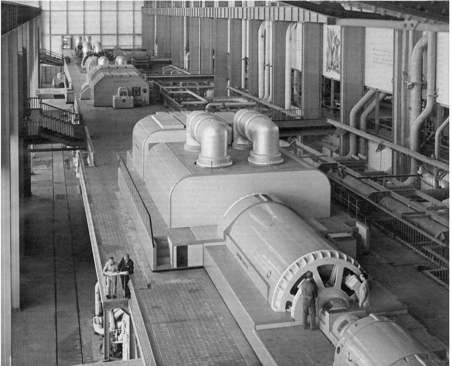
▲ Eine der grössten von Brown Boveri bisher gelieferten Dampfturbinen mit einer Leistung von 175 000 kW bei 3000 U/min ist neben anderen Brown Boveri Gruppen im Dampfkraftwerk Amer (Niederlande) seit Herbst 1960 in Betrieb.
