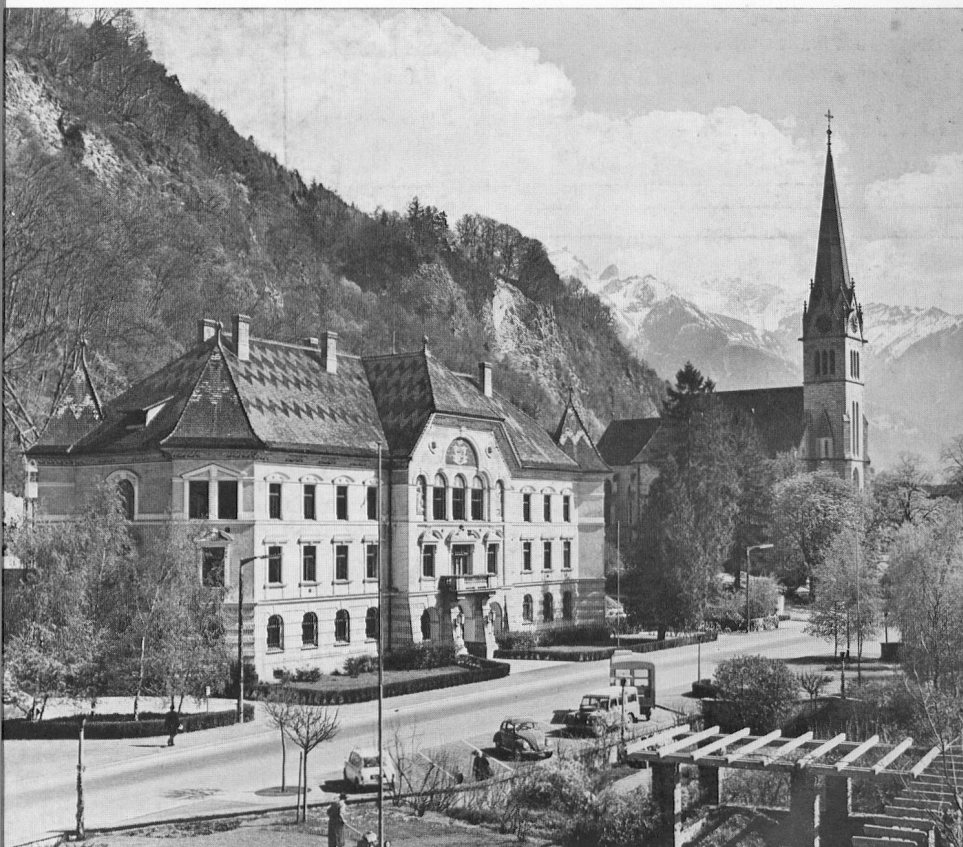
Regierungsgebäude in Vaduz
