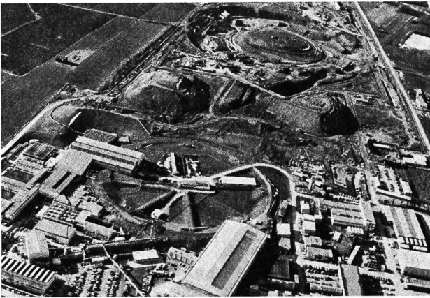
Abbildg. 38 Bauphase der CERN-Speicherringe Sommer 1968
