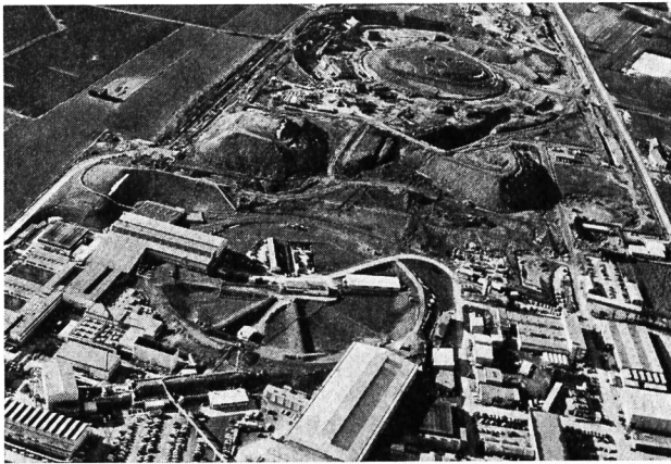
Abbildg. 38 Bauphase der CERN-Speicherringe Sommer 1968
