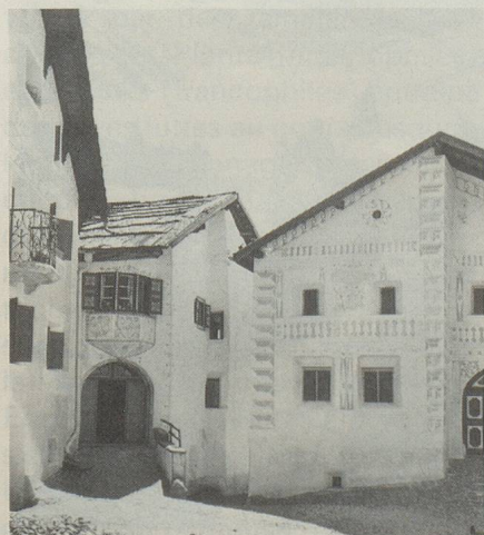
Maisons typiques à Guarda
