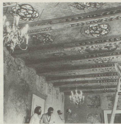
... et après rénovation
