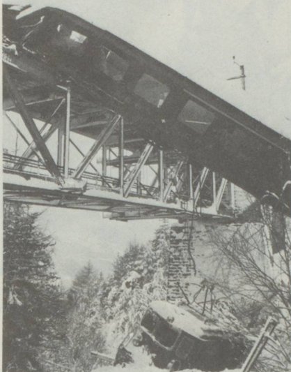
De graves chutes de neige ont perturbé le trafic en Suisse; sur la ligne du Lötschberg une avalanche a provoqué un terrible accident.
