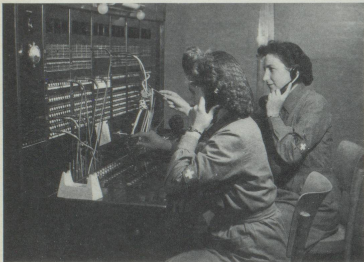
Poste de gué aérien
