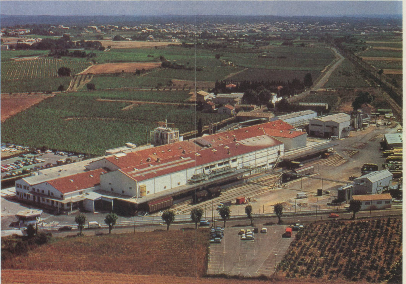
Vue aérienne de l'usine
