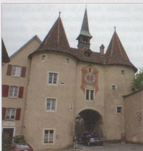
Porrentruy, Porte de France
