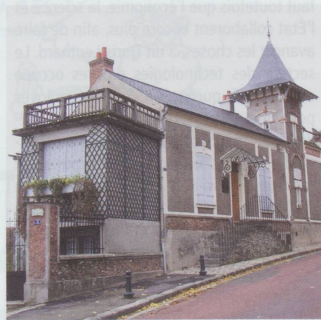
Maison de Ravel à Montfort-l'Amaury
