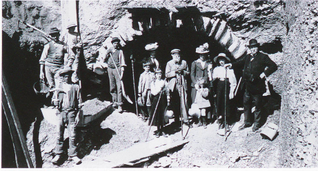
Adolf Guyer-Zeller et sa famille en visite sur le chantier en 1897
