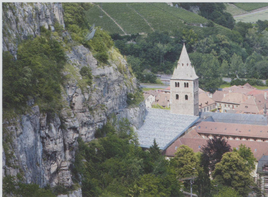
Vue aérienne de l'abbaye de Saint-Maurice.
