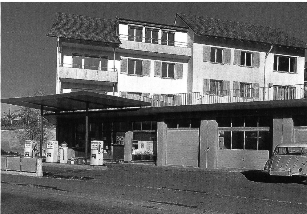
An Stelle des Strumpferheimets steht seit Mitte der sechziger Jahre an der Einmündung von der Luzern- in die Spitalstrasse ein Mehrfamilienhaus. Aufnahme 1967.
