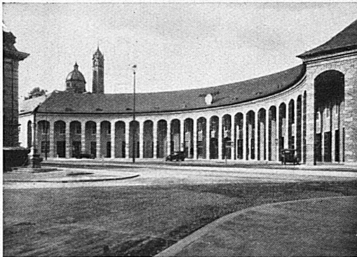
Bahnhof Enge, Zürich Arch. Gebr. Pfister
