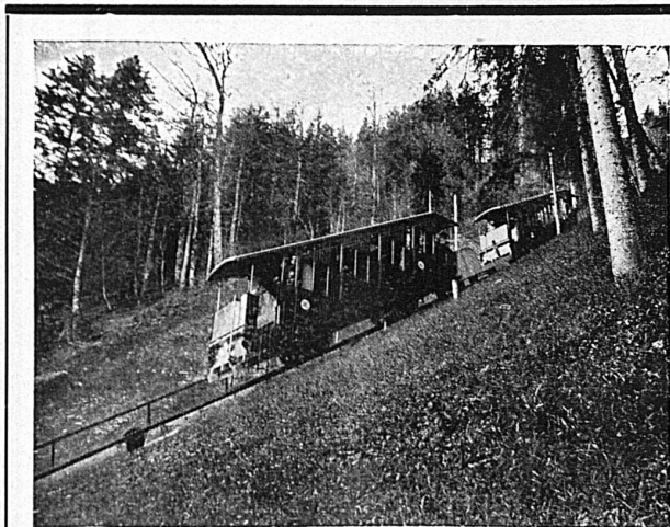
Standseilbahn Engelberg—Gerschnialp mit Wagen für 50 Personen und vorgelegten Güterwagen für Wintersportgeräte
