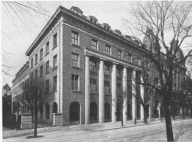
Verwaltungsgebäude des Geschäftssitzes Zürich Hôtel du siège de Zurich
