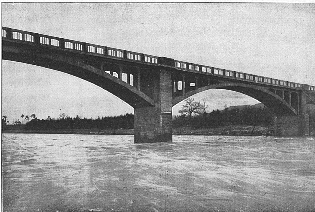
Strassenbrücke über die Thur bei Weinfelden
