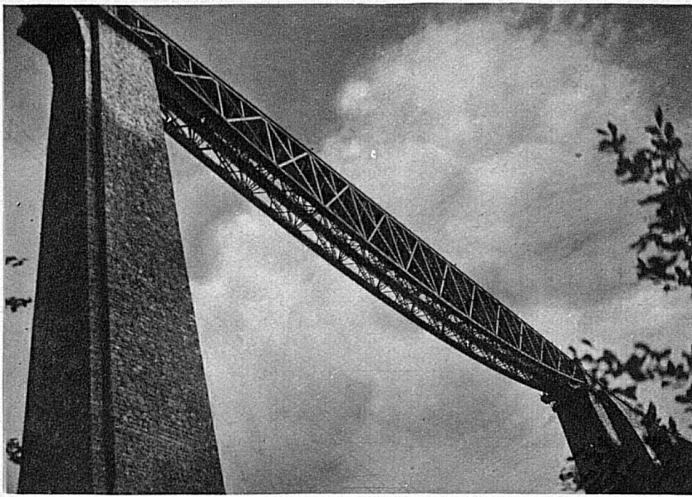
Die Sitterbrücke der BTB mit dem höchsten Brückenpfeiler Europas
