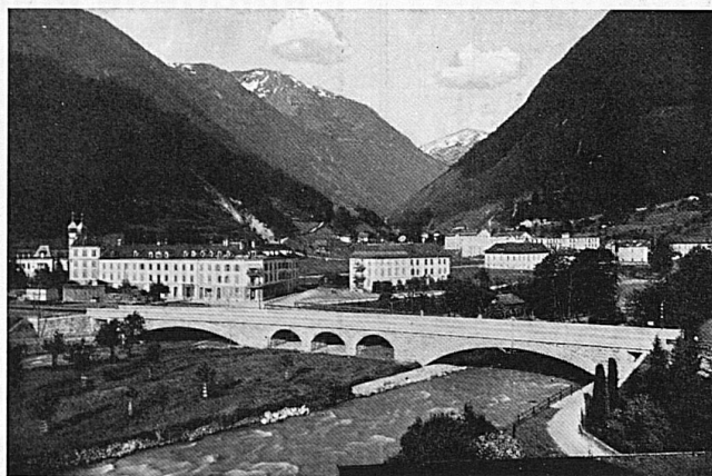
Eisenbahnbrücke der SBB über die Linth bei Schwanden
