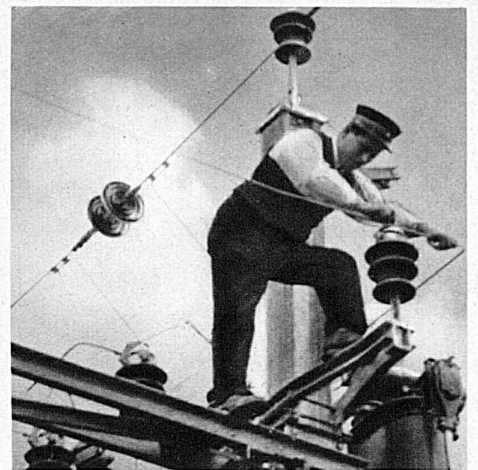
Die Montage der Fahrleitungen erfordert grosse Sorgfalt
