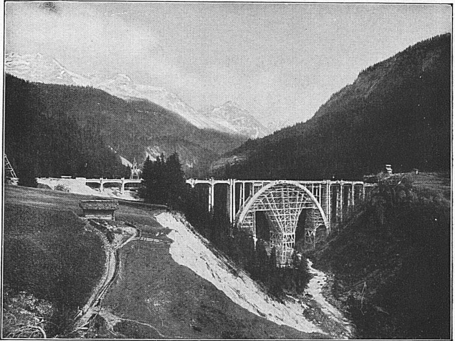
Viadukt bei Langwies während der Bauausführung
