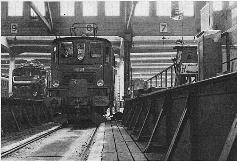
Die Schiebebühne: ein einziger Mann versorgt alle Lokomotiven, wie Spielwaren; mit einem Hebelgriff bringt er die 120 Tonnen an ihren Platz
