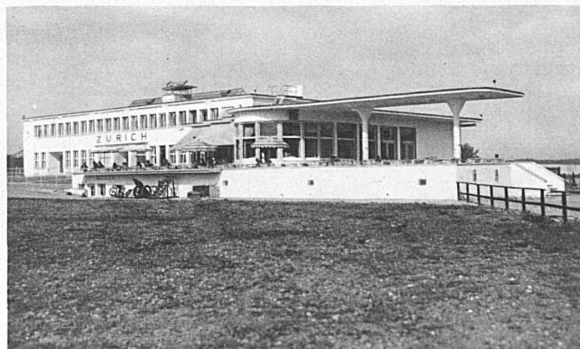
Grossrestaurant Zivillflugplatz Dübendorf Architekten: Kündig & Oetiker, Zürich
