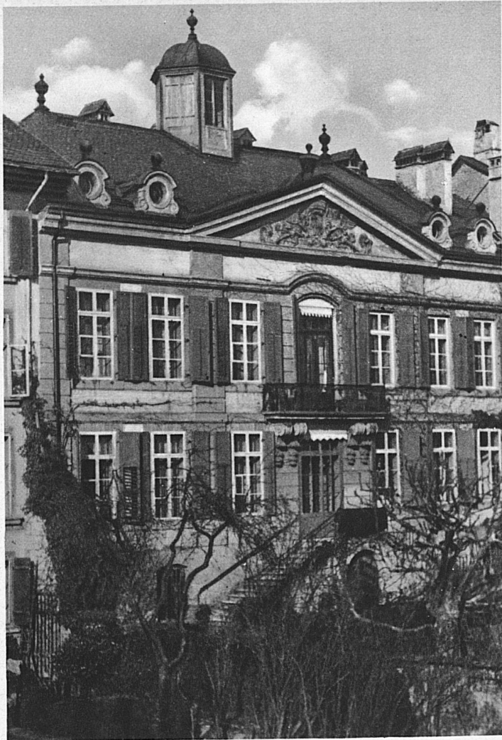
Berne: Façade de l'hôtel Frisching
