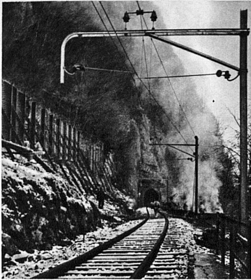
Am Wallensee, zwischen Ofenegg-Weisswand- und Standenhorn-tunnel sind im vergangenen Monat die eisernen Schutzwände gegen Steinschlaggefahr erneuert worden. Unser Bild zeigt die Arbeitsstelle, von der die Rauchsäule des Teerofens aufsteigt – Au bord du Wallensee, entre Ofenegg-Weisswand et le tunnel de Standenhorn, on a été obligé de remplacer, le mois dernier, les murs de défense contre les avalanches. On voit, sur notre photographie, les colonnes de fumée qui montent des fourneaux de goudron du chantier du travail
