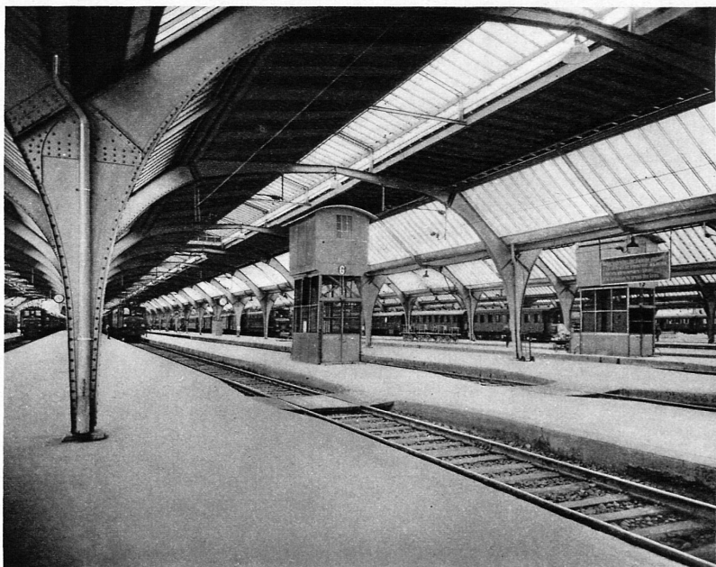
Eine Sinfonie in Stahl und Glas: der werdende Hauptbahnhof Zürich – Nouvelle gare de Zurich: symphonie de verre et acier
