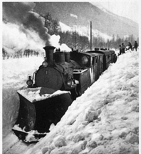
Gewaltige Schneemassen bedecken jeden Winter das Trasse der Furka-Oberalp-Bahn. Schneepflug und zahlreiche Arbeiter halten das Geleise frei – Le chasse-neige et l'équipe alerte des déblayeurs s'unissent pour frayer un passage aux trains de la ligne Furka-Oberalp
