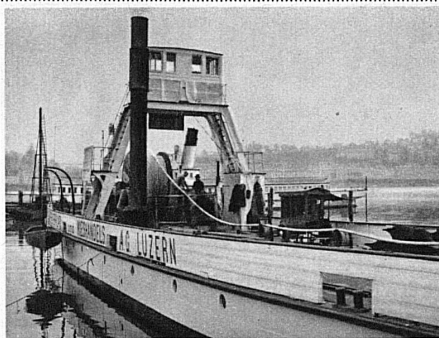
Verlegung eines Telephonkabels von 1270 m Länge und 18 Tonnen Gewicht im Vierwaldstättersee (Seetiefe 120 m) zwischen Treib und Brunnen für die Schweiz. Telephonverwaltung. November 1935 Umwickeln des Kabels vom Bahnwagen auf das Verlegungsschiff in Luzern
