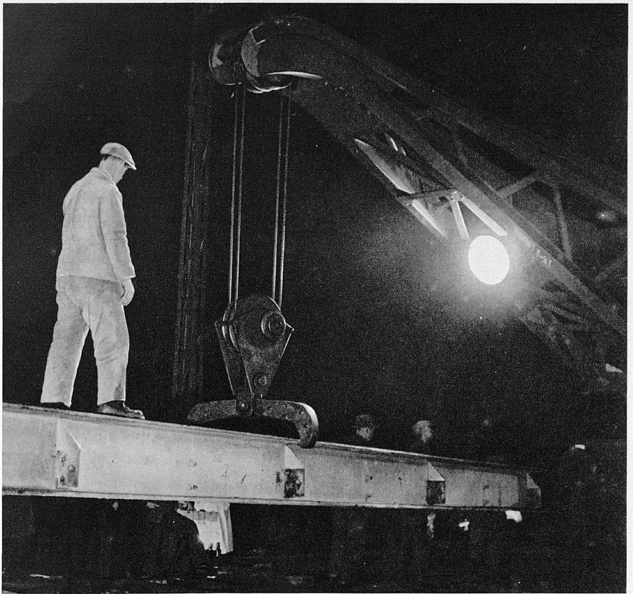
11.35 Uhr. Einmal mangelt es am Gleichgewicht. Ein Arbeiter stellt sich auf die minder schwere Hälfte und sorgt auf diese Weise dafür, dass die Brücke in gerader Balance vom Kranwagen fortgeschafft werden kann
