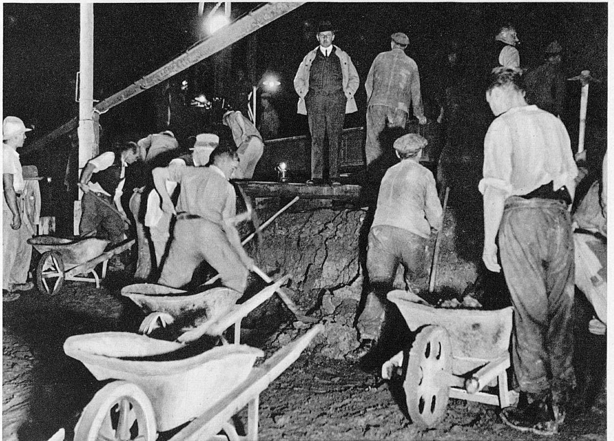
11.45 Uhr. Die härteste Arbeit der Nacht – im wahrsten Sinne des Wortes – beginnt, die Abtragung des Erdkerns, der den Pickeln und Spaten erbitterten Widerstand entgegenbringt. Die Erde birgt mehr Stein, als man vermutet hat, der zähe Lehm trotz selbst den Brechstangen
