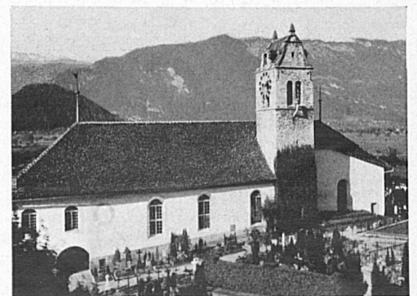
Die Kirche von Wilderswil bei Interlaken L'église de Wilderswil près d'Interlaken
