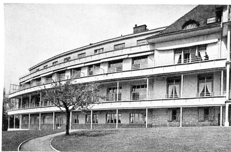
Spital Wetzikon, Kt. Zürich: Ansicht der Neubautteile (1934). Beispiel eines modernisierten Kreisospitals.
