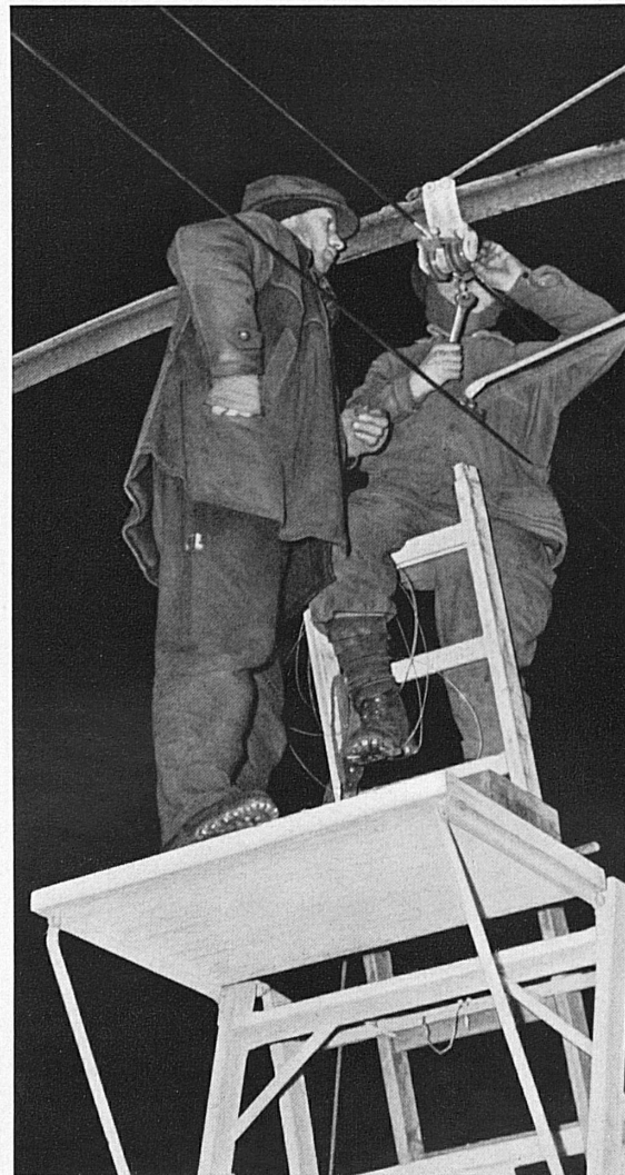
Links: Sind beide Drähte auf eine Strecke von 500 bis 800 m ausgelegt, so spannt man sie ein erstes Mal mit Hilfe von Muffen und Dynamometern. Links, darunter: Früh um 1 Uhr wird eine wohlverdiente viertelstündige Imbißpause eingeschaltet.
