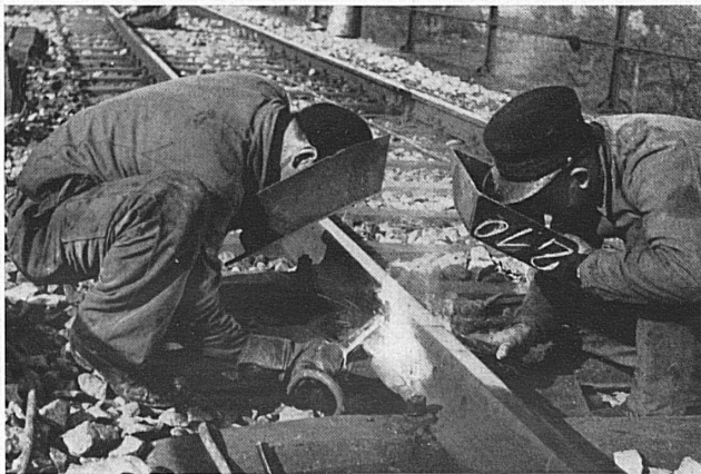
Elektrische Schienenstoß-Schweißung in einem Hauptgeleise der SBB.
