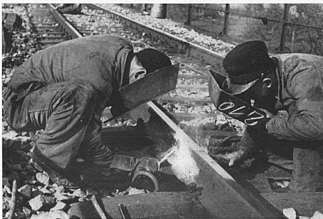
Elektrische Schienenstoß-Schweißung in einem Hauptgeleise der SBB.
