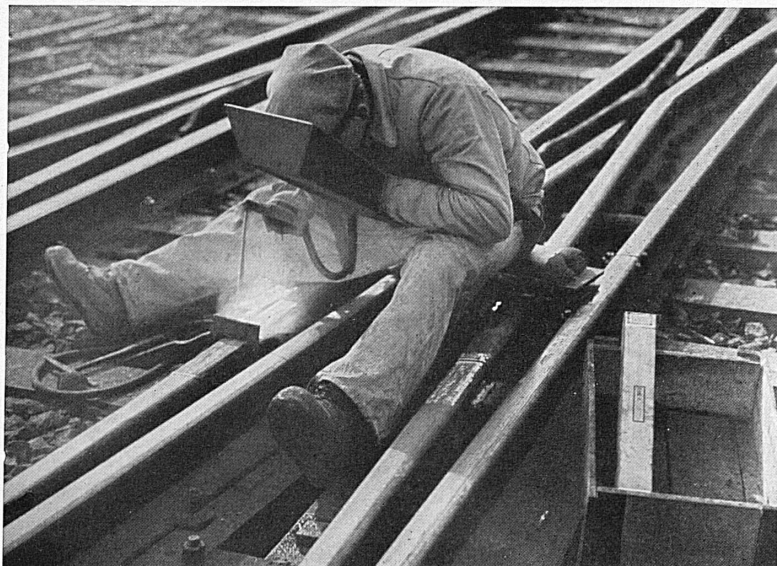
Unterhalts-Schweißarbeiten in einem SBB-Bahnhof
