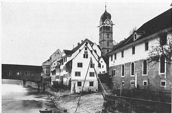
Häusergruppe bei der Kirche von Eglisau vor dem Abbruch (rechts Salzhaus, links alte Holzbrücke).* Groupe de maisons près de l'église d'Eglisau avant la démolition (à droite le «Salzhaus», à gauche le vieux pont de bois).
