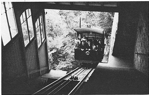
Links: Die Drahtseilbahn von Kehrsiten in die Höhe bildet die Hauptzufahrt des Bürgenstocks. Sie datiert aus dem Jahre 1888.
