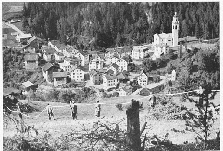
Die Auslegung des Telephonkabels bei Tiefencastel. Câble téléphonique près de Tiefencastel.
