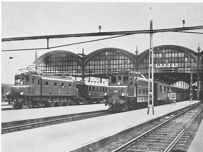
Unten: Der Bahnhof Basel SBB nach Aufnahme des elektrischen Betriebes auf der Strecke Olten—Basel (via Gelterkinden) im Mai 1924.
