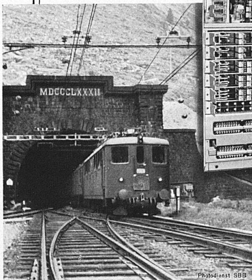
Gotthard- tunnel Nordseite
