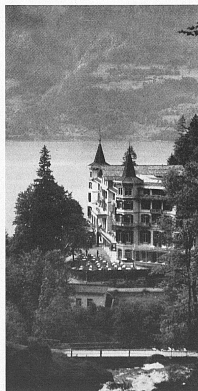
Unten: Das Parkhotel Gießbach wurde nach umfassender Renovation und Modernisierung — alle Einrichtungen sind elektrisch — diesen Sommer wieder eröffnet. — En bas: L'hôtel du Parc au Giessbach a été rouvert cette année, entièrement rénové et modernisé.
