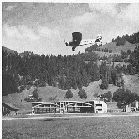
Mit einem gut gelungenen Flugtag wurde der neue Flugplatz von Saanen eingeweiht, der dank seiner landschaftlichen Reize regen Besuch erhalten dürfte. Der neue Hangar weist eine Breite von 40 und eine Höhe von 10 m auf. — L'aérodrome de Gessenay a été inauguré au cours d'une journée d'aviation très réussie. Nul doute que le charme du paysage n'y attire de nombreux aviateurs. Le nouveau hangar mesure 40 m. de large et 10 m. de haut. Photo: ATP.
