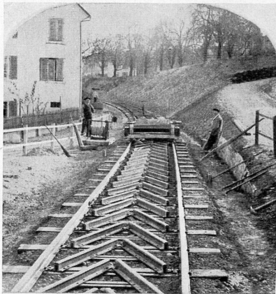
Oben: Die Zahnwalzenstange nach dem System Wetli (1876).
