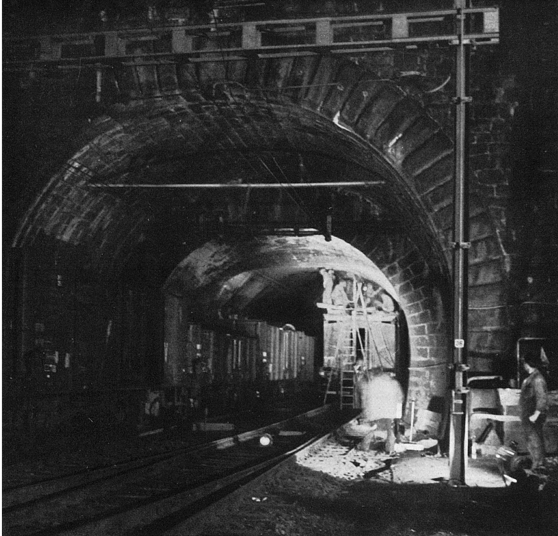
A gauche: Réparation à l'entrée nord du tunnel du Gothard.
