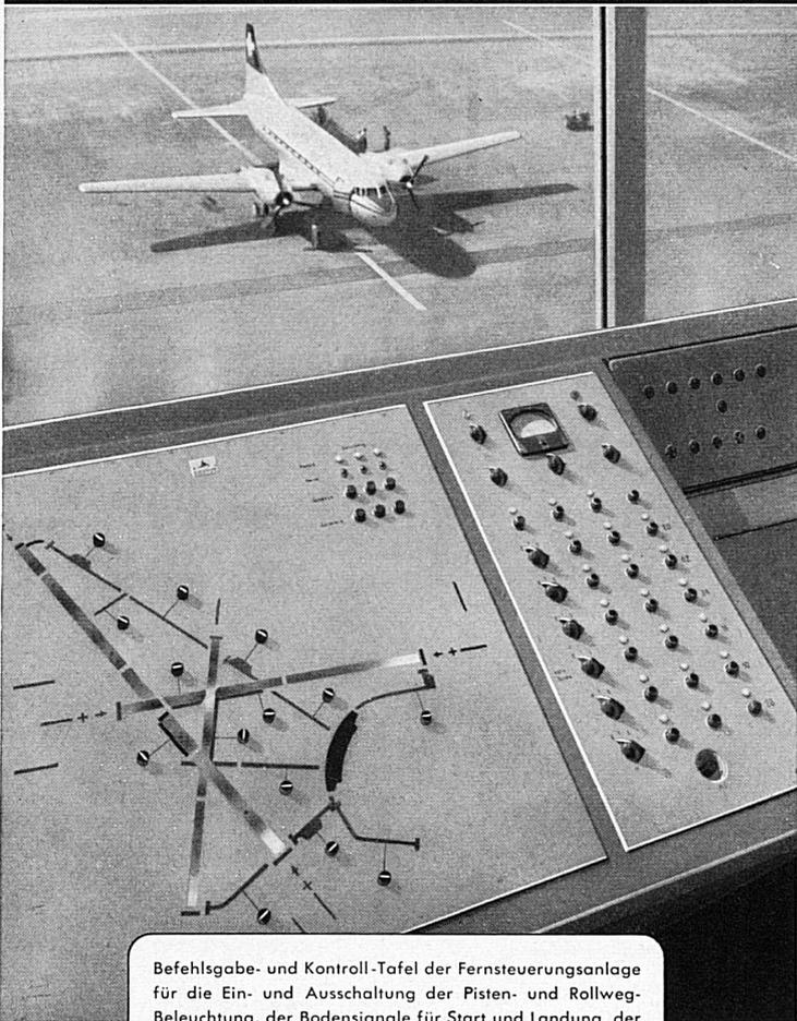
Befehls- und Kontroll-Tafel der Fernsteuerungsanlage für die Ein- und Ausschaltung der Pisten- und Rollweg-Beleuchtung, der Bodensignale für Start und Landung, der Anflugschneisen und der Hindernis-Markierungslichter.
