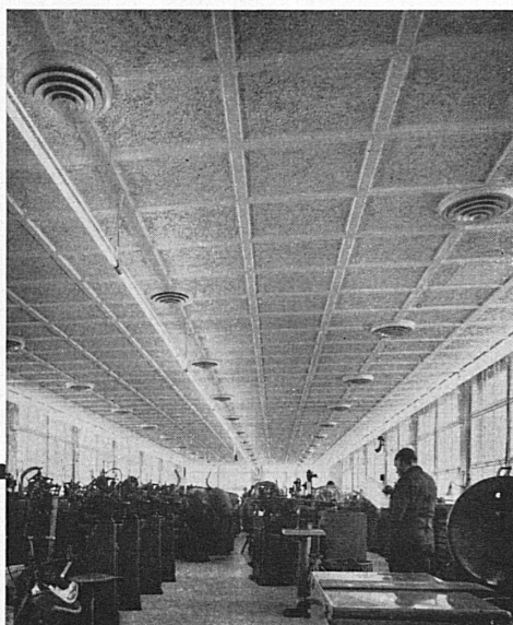
Klimaanlage «System Häusler» in Uhrenfabrik
