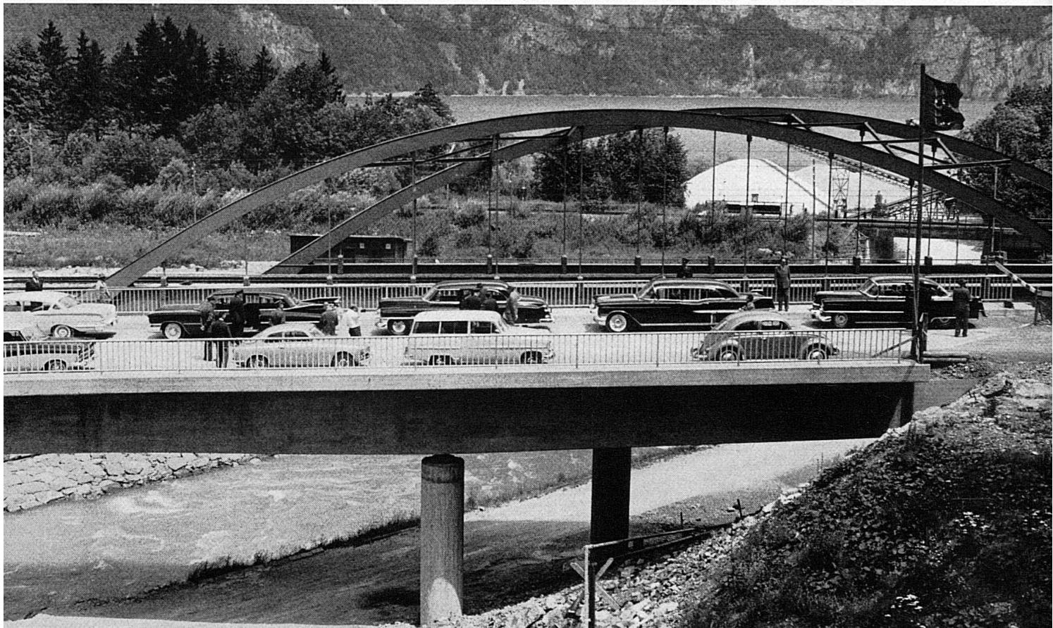
In Zusammenarbeit von Schiene und Straße sind «im Gäsi» an der Mündung des Escherkanals in den Walensee zwei neue Brücken gebaut worden. Diese, wie die Tunnelbauten, erhielten im Juli bundesrätlichen Besuch. Hinter der Straßenbrücke aus vorgespanntem Beton, die der Kanton Glarus für die Walenseetalstraße errichtete, erblicken wir die neue stählerne, doppelpurige Bahnbrücke der SBB.
