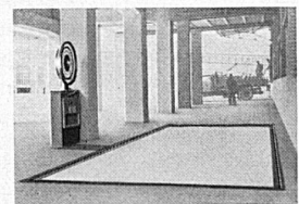
Brückenwaage für Straßenfahrzeuge. Wägefähigkeit 30 000 kg mit automatischer Gewichtsanzeige und Registrierung
