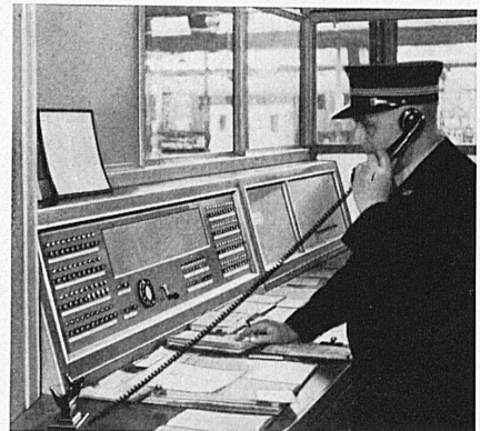
ALBIS-Telephon-Anlage bei den SBB
