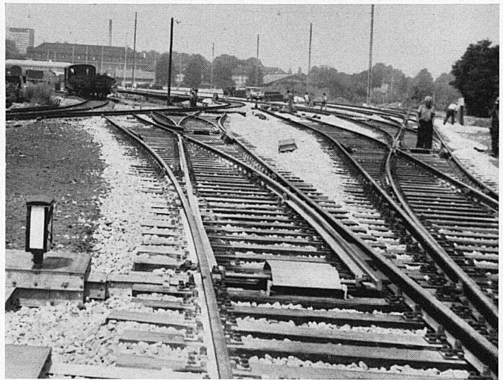
Ausbau Basel GB
